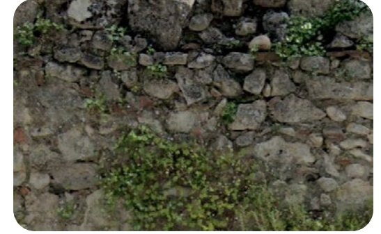
Muro in pietra
