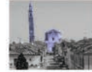
/39 CHIESA E CAMPANILE DI S. ANTONIO, CASTELMASSA
