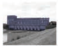
12 IMPIANTO IDROVORO SAN SIRO, MIRASOLE
