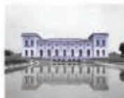
5 IMPIANTO IDROVORO TRAVATA, BAGNOLO SAN VITO
