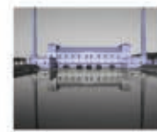
28 IMPIANTO IDROVORO MANTOVANO REGGIANO, MOGLIA
